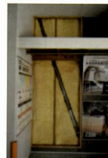
地震の揺れによる住宅の損傷を防ぐ制振ダンパー
