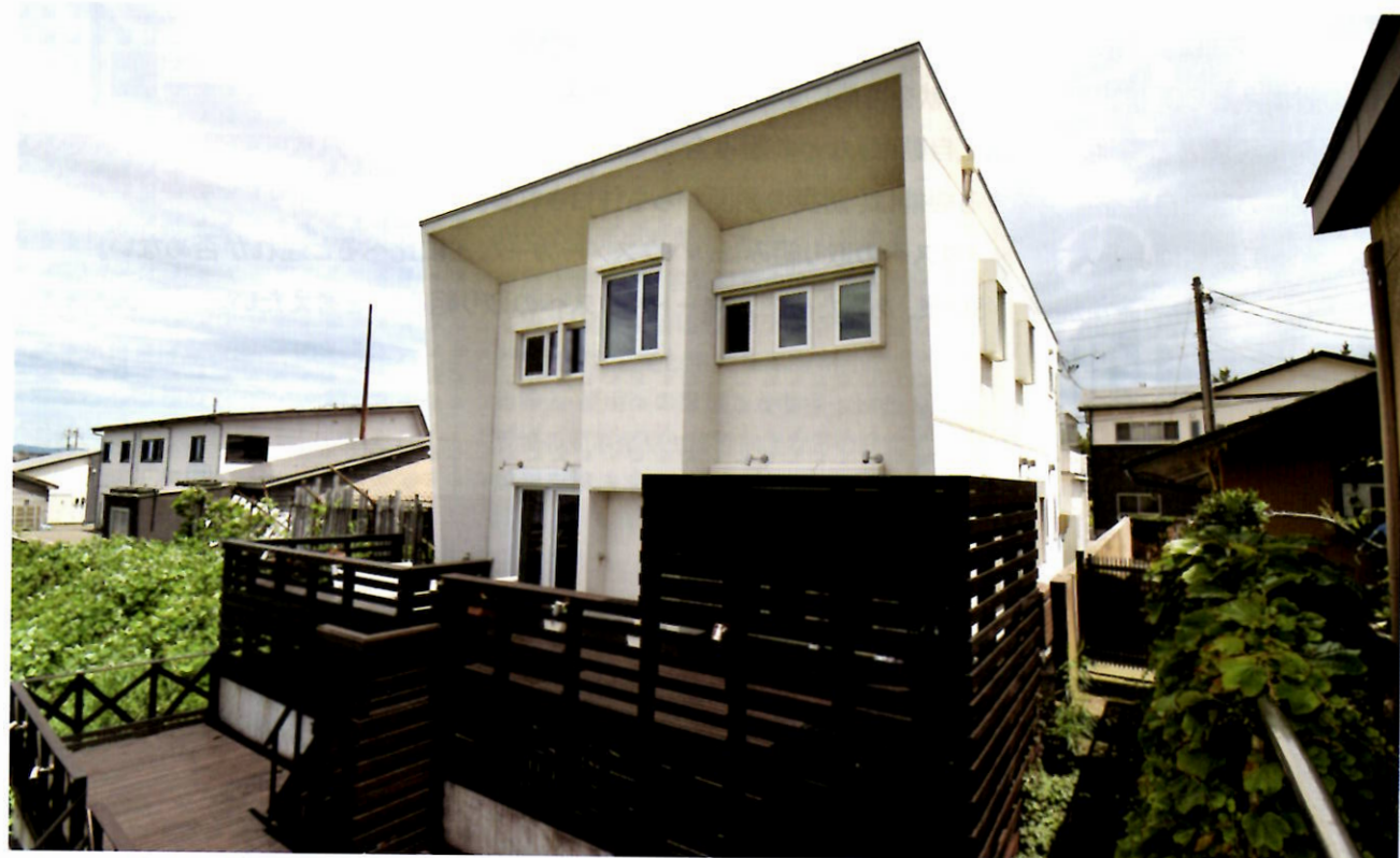
エスイーイーが新潟県上越市内にオープンしたスマートハウスの実棟モデル「Smart2030 零和の家」。BELS 評価「★★★★★ZEH」、設計一次消費エネルギー消費量 322MJ/m 2 ・年、設計一次消費エネルギー削減率 55%、UA 値 0.44W/m 2 K (見学申し込み https://sea-consulting.co.jp/ )
