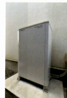
9.8kWh・200V、100V 住宅対応蓄電池システム
