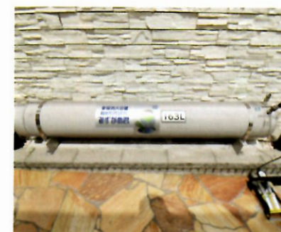
断水時でも飲料水・生活用水を供給できる大容量の非常用貯水タンク
