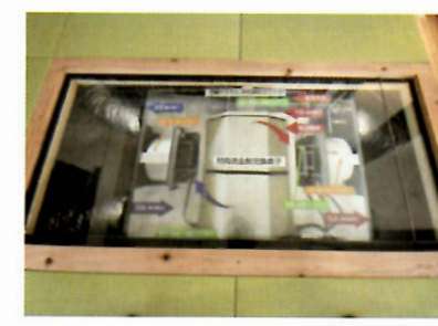
“正圧”状態を保つ気圧調整式第一種全熱交換気システム
