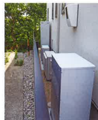
大容量の太陽光発電とAI蓄電池(写真手前)でエネルギー自給率100%を実現。停電時はエコキュート(写真奥)等の200V機器も動かし普段通りの生活が可能。
